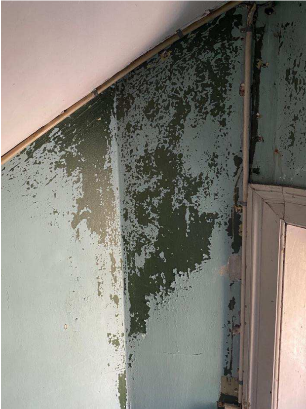
Vægoverflader i trapperum
