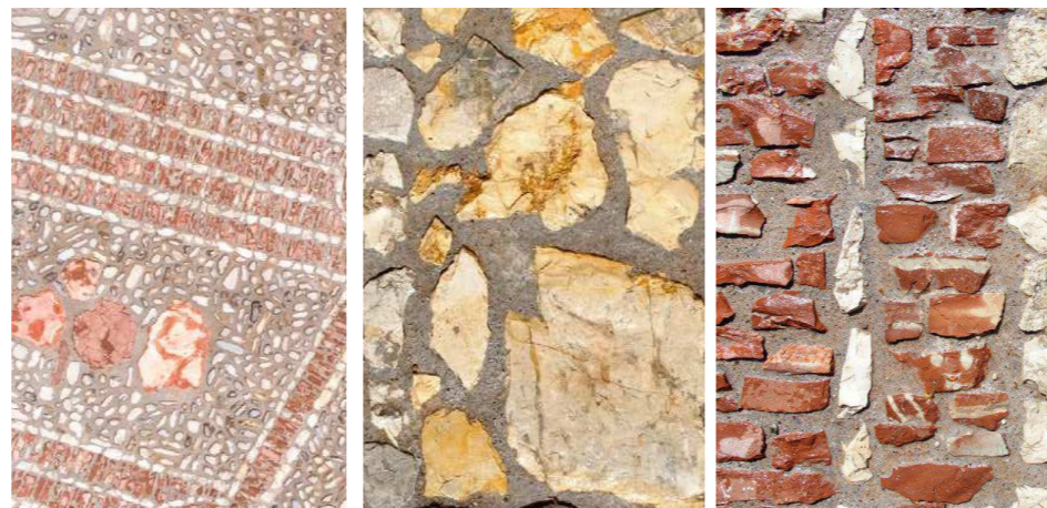
Eksempler på genbrug af mursten fra baghuset til at tegne baghusenes omrids som spor i belægningen.
