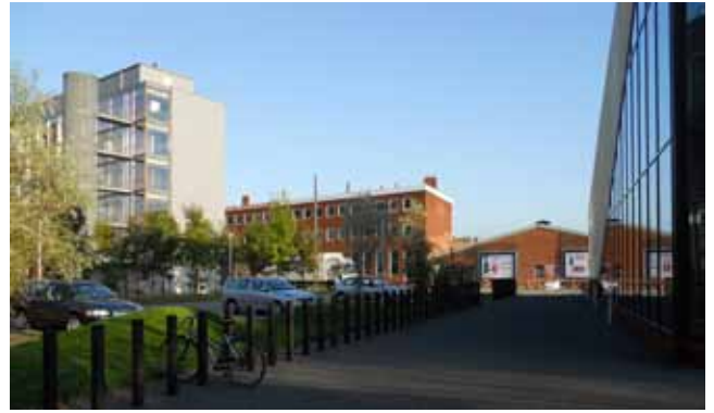
Et kig fra Metropolitets udeareal. De to røde bygninger ved Rådmandsgade forudsættes nedrevet. Industrikollegiet ses til venstre.
