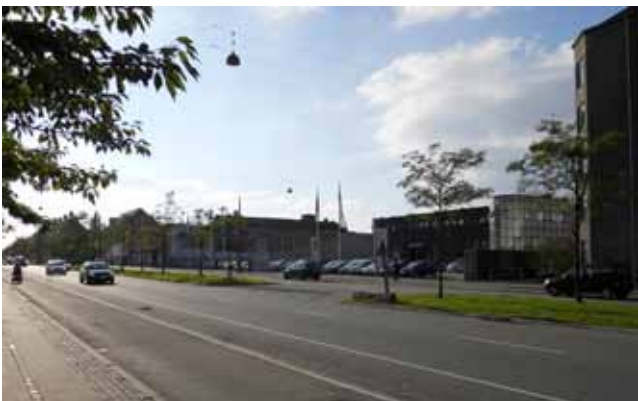
Kig mod sydvest ad Jagtvej med Skrivergangen til højre. De lave erhvervsbygninger i midten af billedet forudsættes nedrevet.
