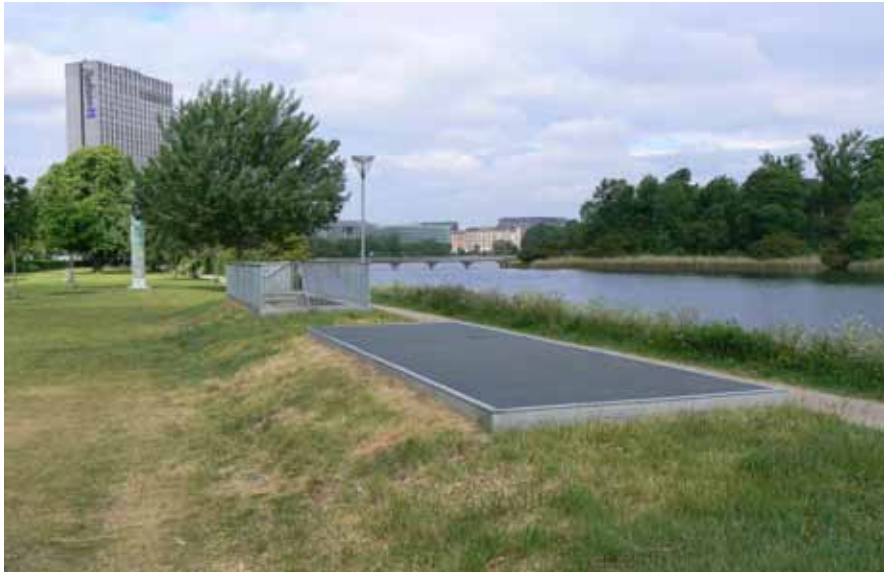
Figur 2.4 Eksempel på ventilationsrist og trappe til skakt. Det viste eksempel er fra Enveloppeparken ved Stadsgraven.
