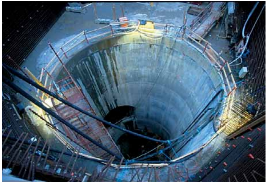
Figur 4.10 Skakt foret med beton på indersiden for opnåelse af jævn og tæt overflade, Københavns Metro.
