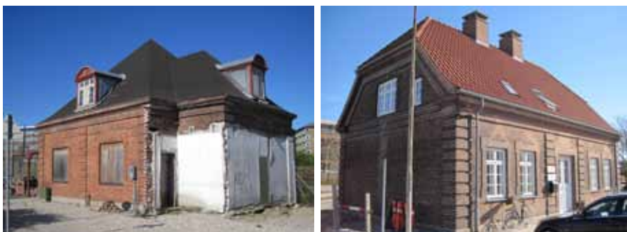
Figur 11.2 De to bevaringsværdige bygninger på Århusgade ved Nordhavn st. Bygningen til venstre er registreret som bevaringsværdig med SAVE-værdi 4, mens bygningen til højre er registreret med SAVE-værdien 3.
