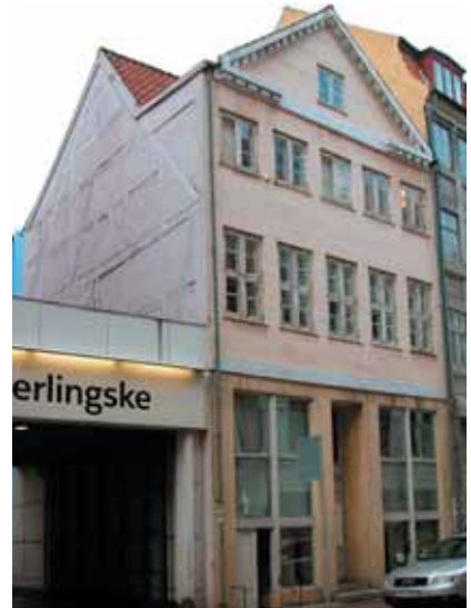
Antonigade 7, hvor der ikke er harmoni mellem under- og overfacade, og hvor butiksvinduerne virker meget dominerende på det samlede facadeudtryk.
