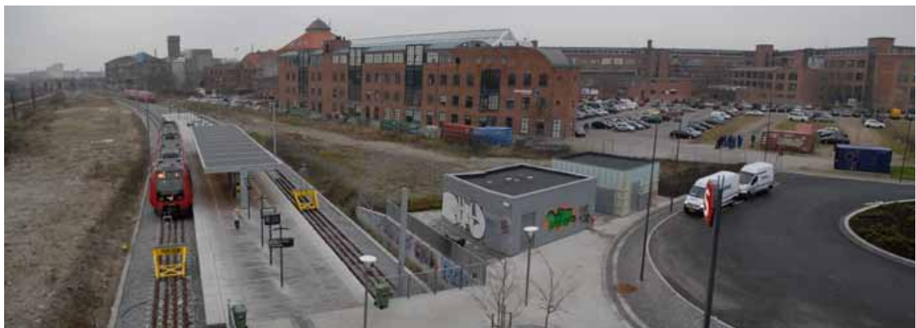
Arealet nord for Ringbanen indgår i det fremtidige fodgængerstrøg med et opholds- og aktivitetsområde og en strækning af den grønne cykelrute "Valbyruten".
