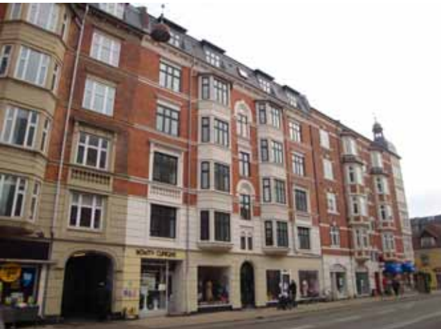
Amagerbrogade 125-133 opført 1904-1907 har høj bevaringsværdi
