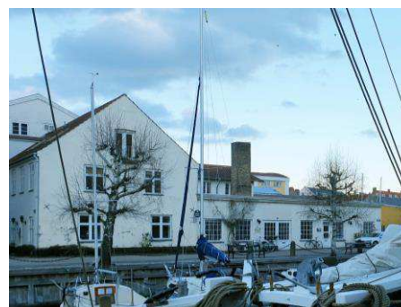
Eksisterende bygning, Wilders Plads 9, set fra vest. Bygningen tv bevares og den lave bygning th. nedrives.
