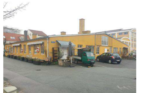
Eksisterende bygning på Wilders Plads 11A og 9B set fra syd. Bygningen nedrives.
