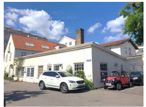
Eksisterende bygninger på Wilders Plads 9 set fra syd. Bygningen i forgrunden (nr. 9B, 9C og 9D) nedrives og de højere bygninger i baggrunden (9A, 9E, 9F og 9G) bevares.
