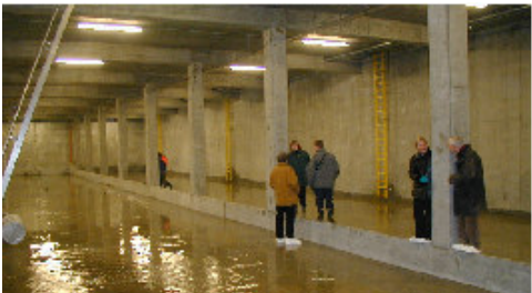
Figur 12: Underjordisk regnvandsbassin
