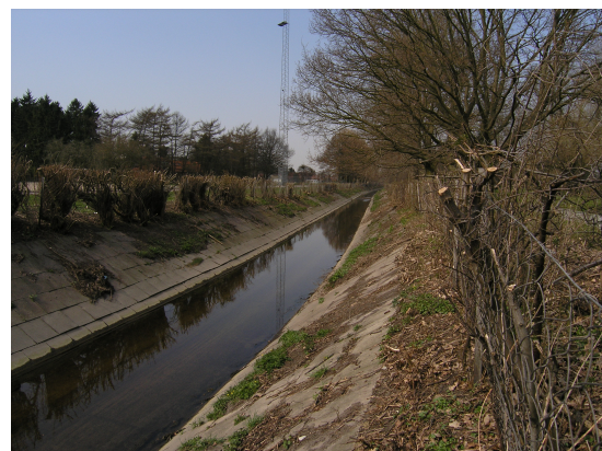
Figur 5: Harrestrup Å på en af de flisebeklædte strækninger
