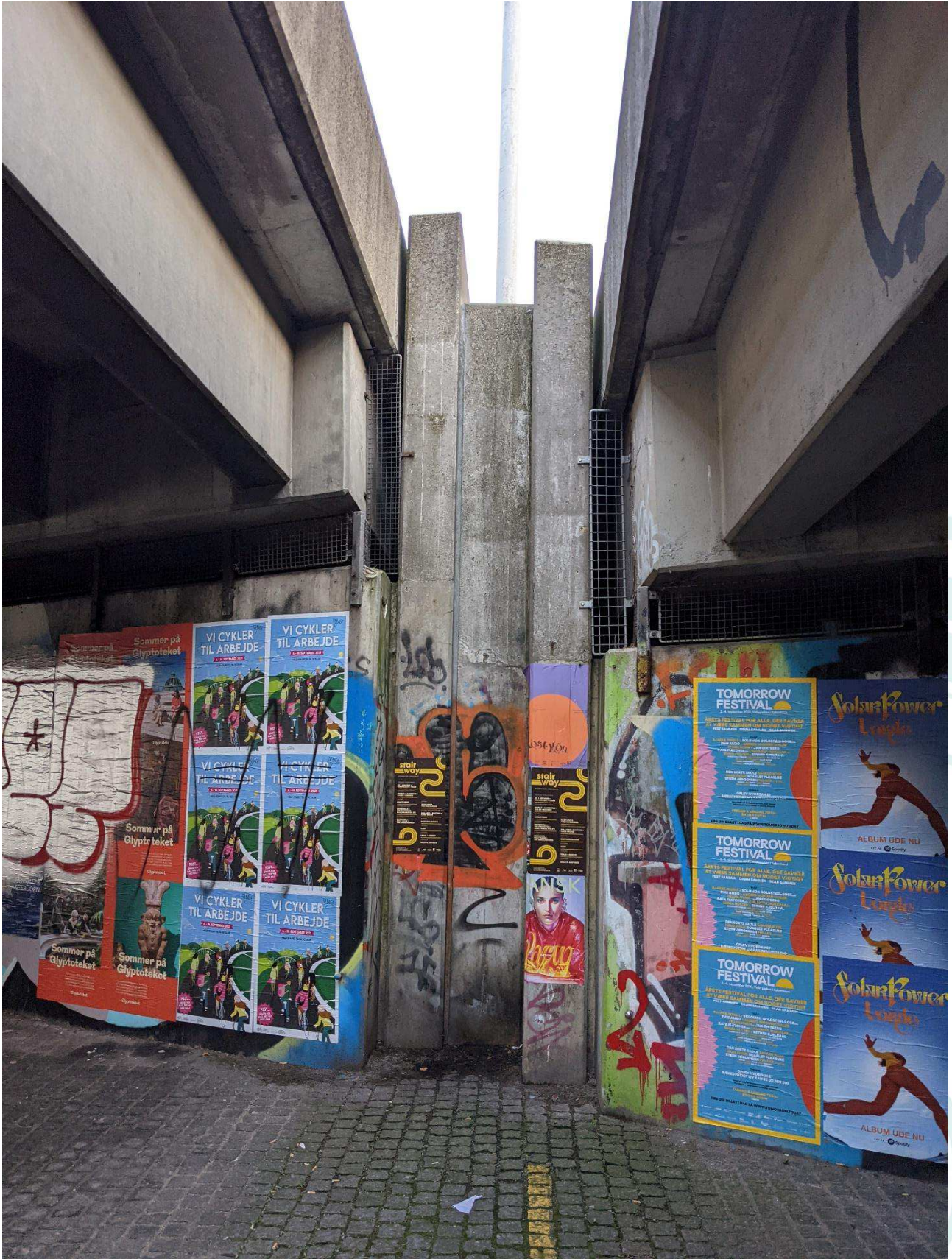
To separate vejbroer samles i en delvist sammenbygget rampe. Den ene kan tages ned, samtidig med at den anden bliver stående // eget foto
