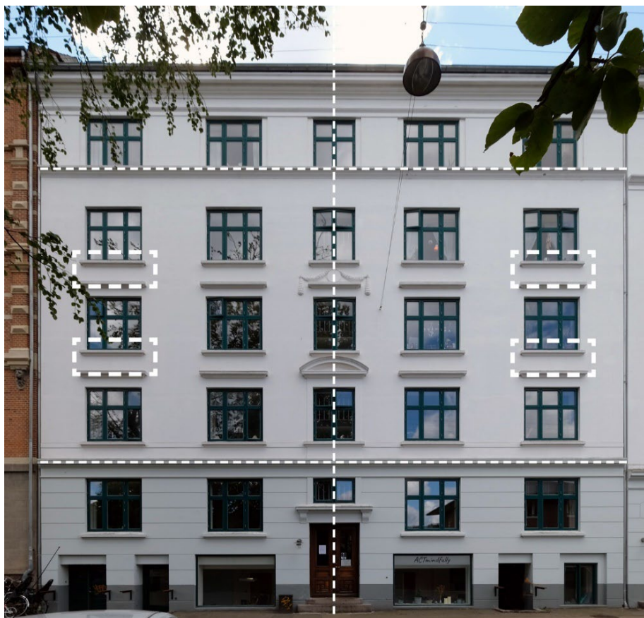
Bygning fra 1902 SAVE-værdi på 4
