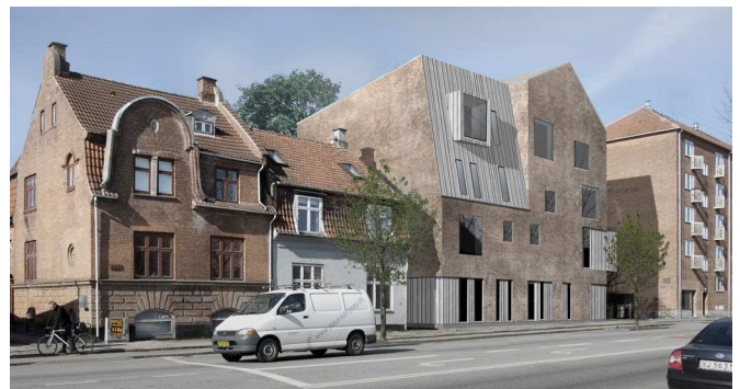
Facade mod Frederikssundsvej (Cornelius + Vøge)
