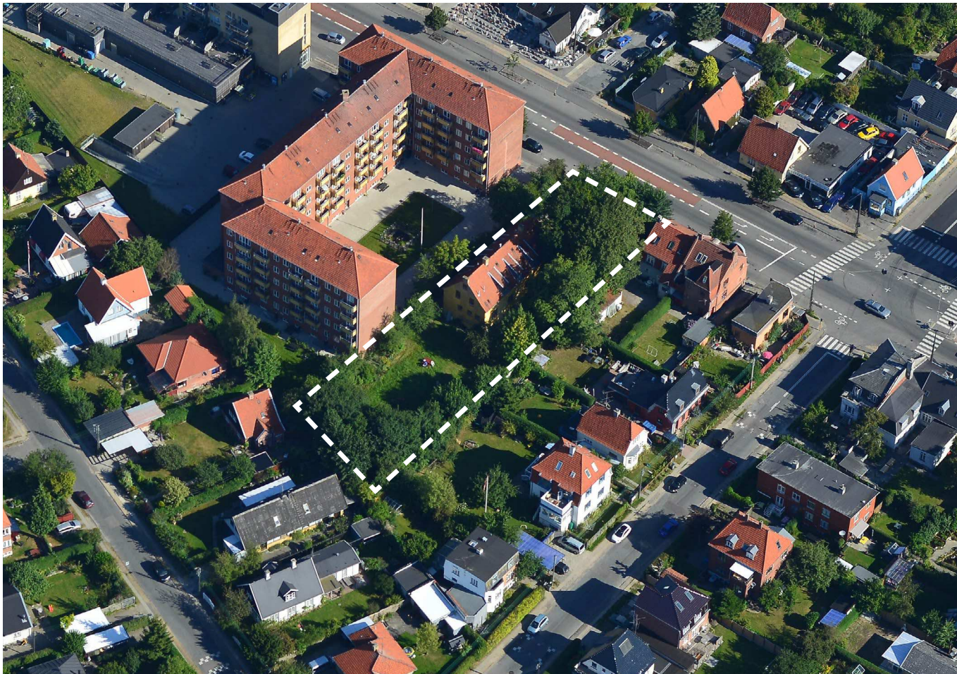
Område omfattet af lokalplantillægget, ejendommen Frederikssundsvej 257. (KK foto)
