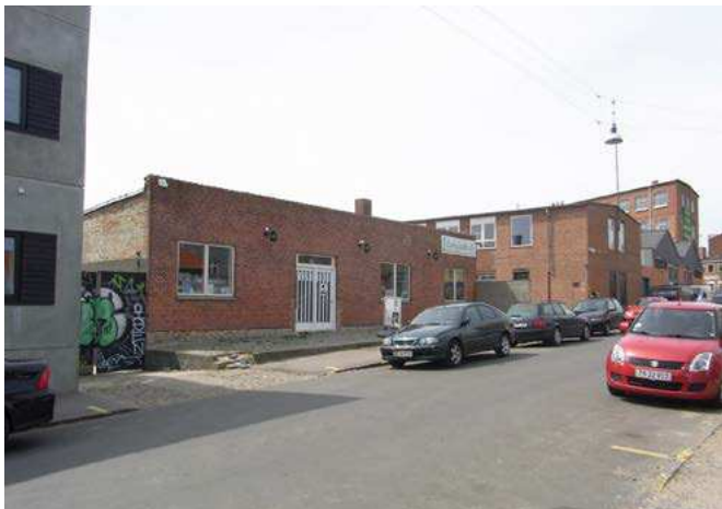
De eksisterende bygninger set fra Dortheavej
