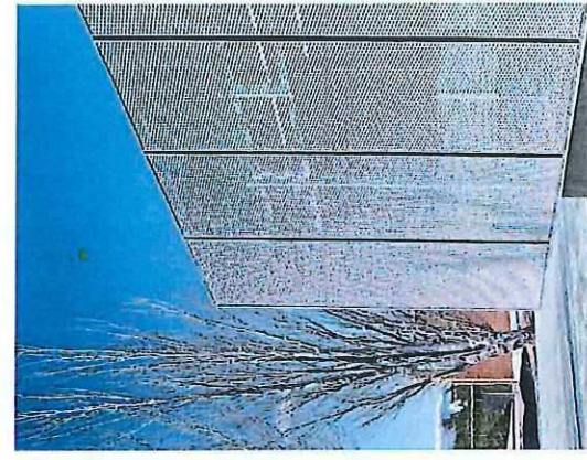
afskærmning med strækmet- al eller elefantrist / galv. stål
