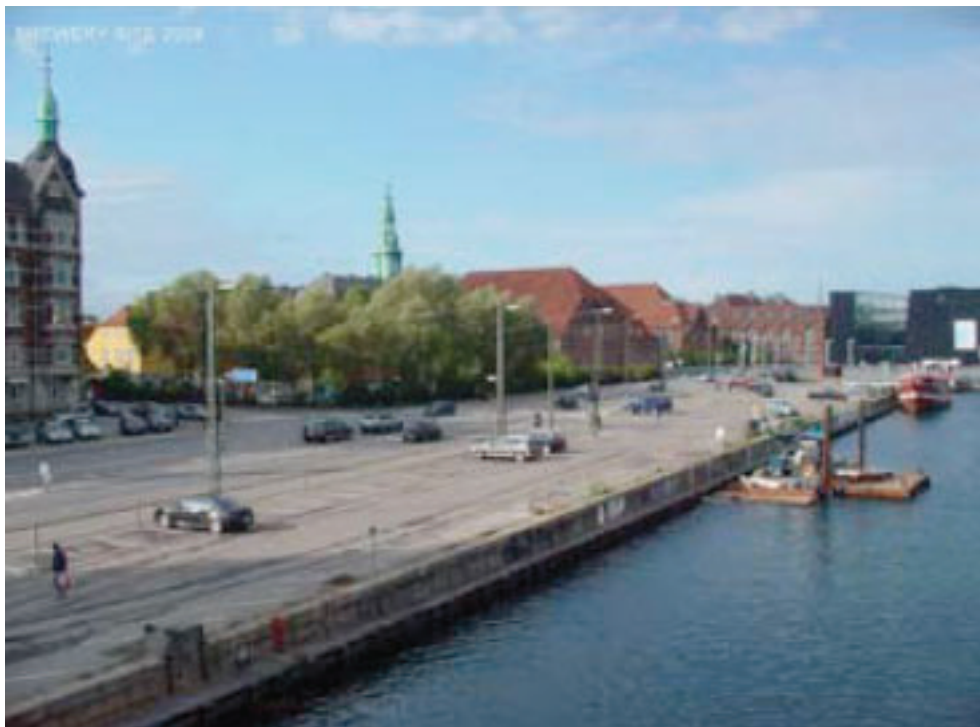
Figur 6-4 Kajen ud for grunden set fra Langebro. Foto COWI.
