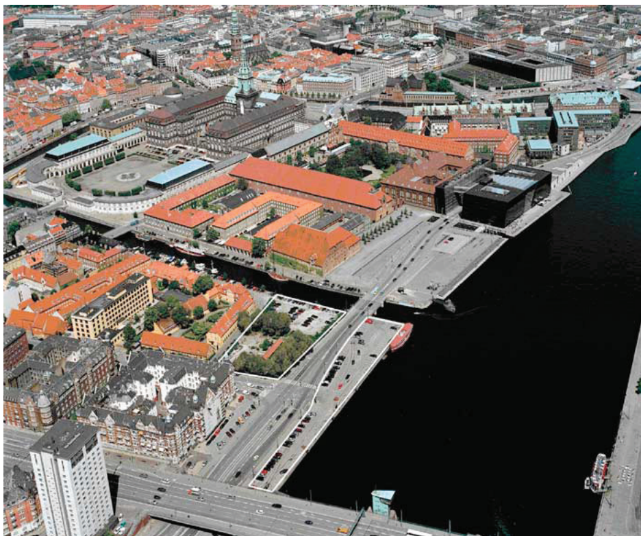
Figur 1-1 Bryghusgrunden ligger ved Københavns havnefront kun få meter fra Den Sorte Diamant, Christiansborg og Nationalmuseet. Byggefelterne for det nye byggeri er vist med hvid streg. Foto: Fonden Realdania.
