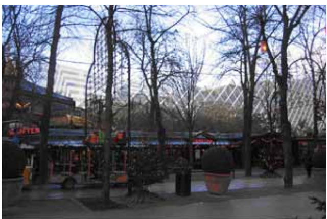
Groften - efter. Nedtrapping af facaden mod Pantomimeteatret.
