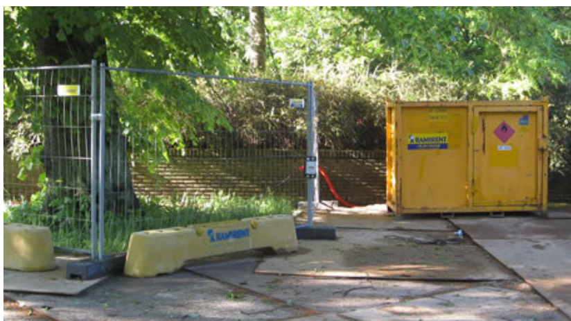
Figur 7.7.4. Træ på byggeplads. Træernes drypzone er ofte sammenlignelig med udbredelsen af træernes rodnet.
