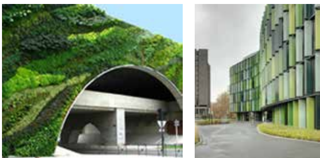
Referencer, der viser forskellige måder, hvormed der med begrønning af facader eller med anden form for facadebehandling kan skabes en landskabsmæssig kobling og variation.
