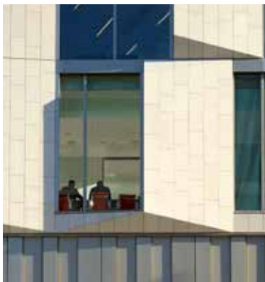
Referencer. To eksempler på materialer og udformning af henholdsvis basen med et vinklet facadeelement i natursten og overbygningen i metalplade, der kan placeres i forskellige vinkler.
