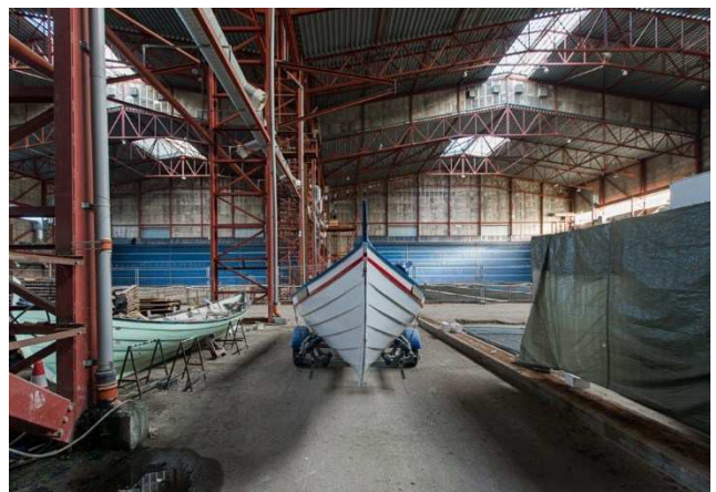
1.6 Eksisterende stålstruktur, Støbehallen
