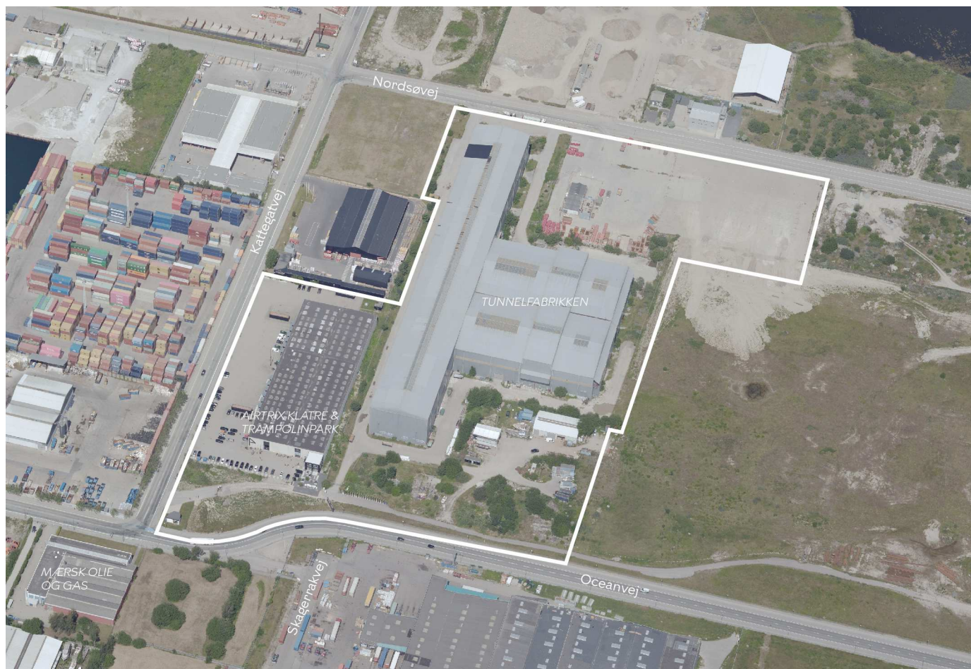
Området set fra syd mod nord. Tunnelfabrikken ligger centralt i lokalplanområdet, der også omfatter Airtrix Klatre & Trampolinpark placeret i lagerbygningen til venstre for Tunnelfabrikken. Lokalplanområdet er indtegnet med hvid linje og de vigtigste, gader, virksomheder og bygninger er navngivet. Luffoto: Kortforsyningen, 2019.
