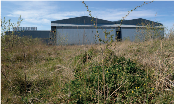
Tunnelfabrikken set fra øst mod vest. Bygningen fremstår med karakteristiske taghældninger og store lukkede facadepartier. Foto: SLA og Arcgency.
