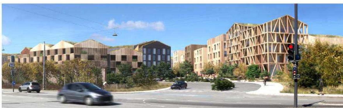
Figur 22. Udsigt fra krydset mellem Vejlands Allé og Center Boulevard, fotostandpunkt 5. Kilde: Bilag 10 - Miljøkonsekvensrapport side 86
