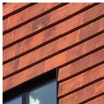
Eksempel på skærmtegl. Foto: Komponent.
