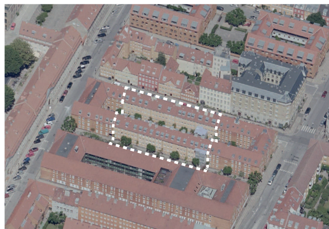
Luftfoto af Rosengade.
