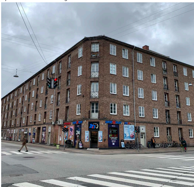
Ejendommen set fra gaden
