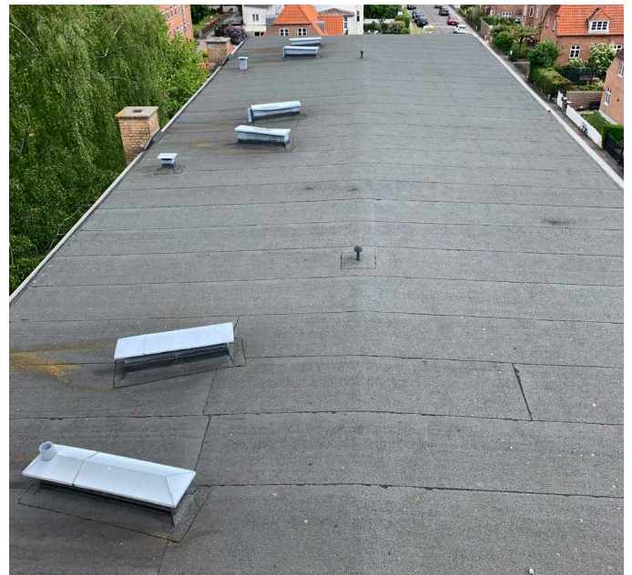
Fladt tag hvor der bliver etableret solceller
