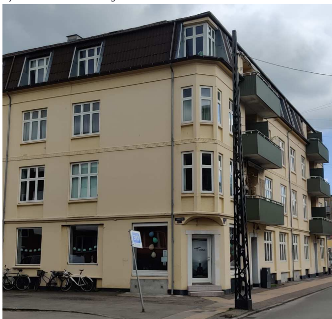
Ejendommen set fra gaden
