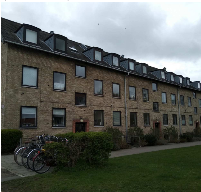
Ejendommen set fra gaden
