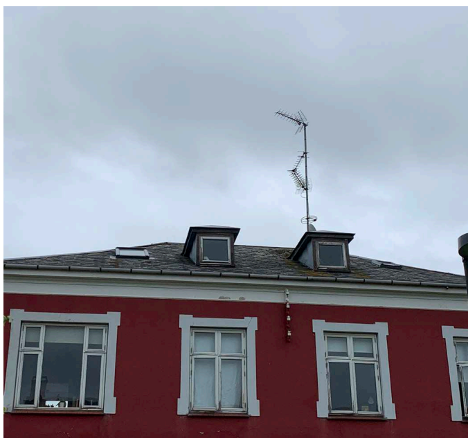
Etablering af ny tagkonstruktion med 2 tagboliger
