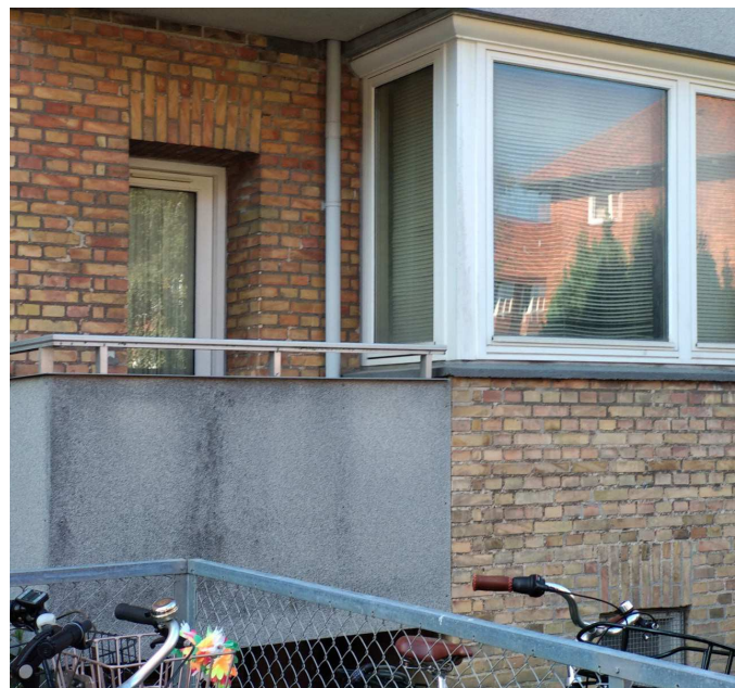
Eksisterende altan- og vinduesparti
