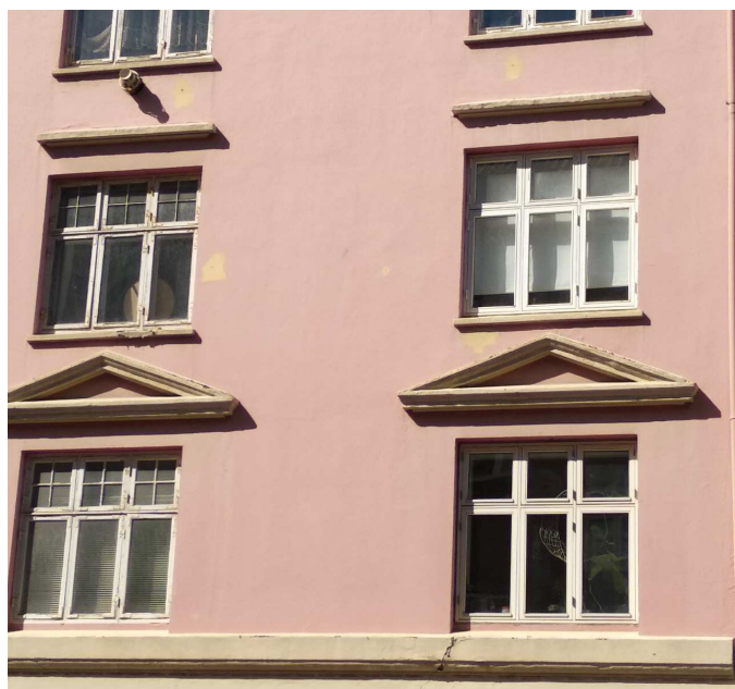
Eksisterende vinduer mod gade
