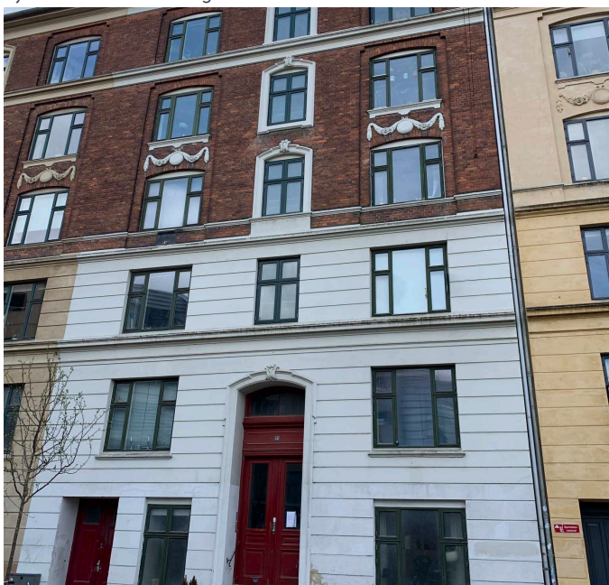
Ejendommen set fra gaden
