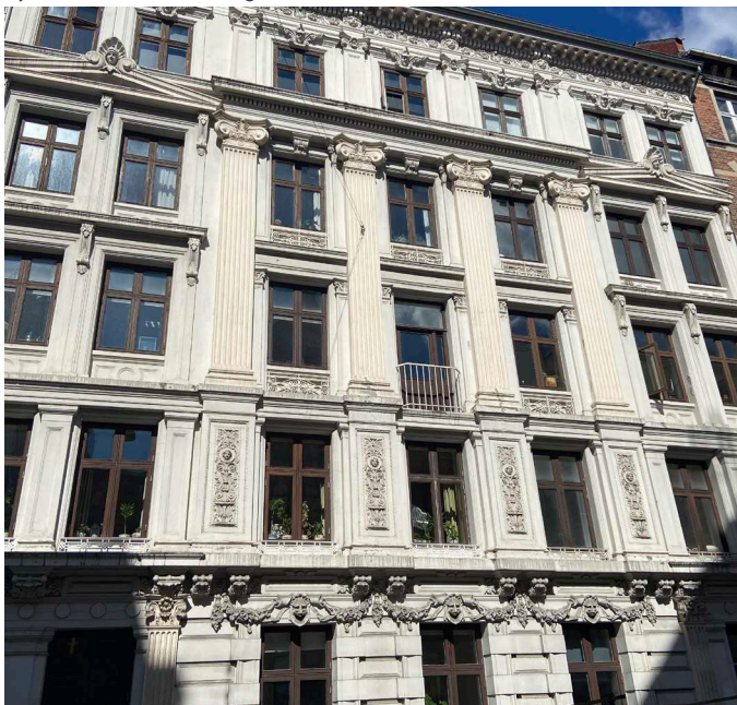
Ejendommen set fra gaden
