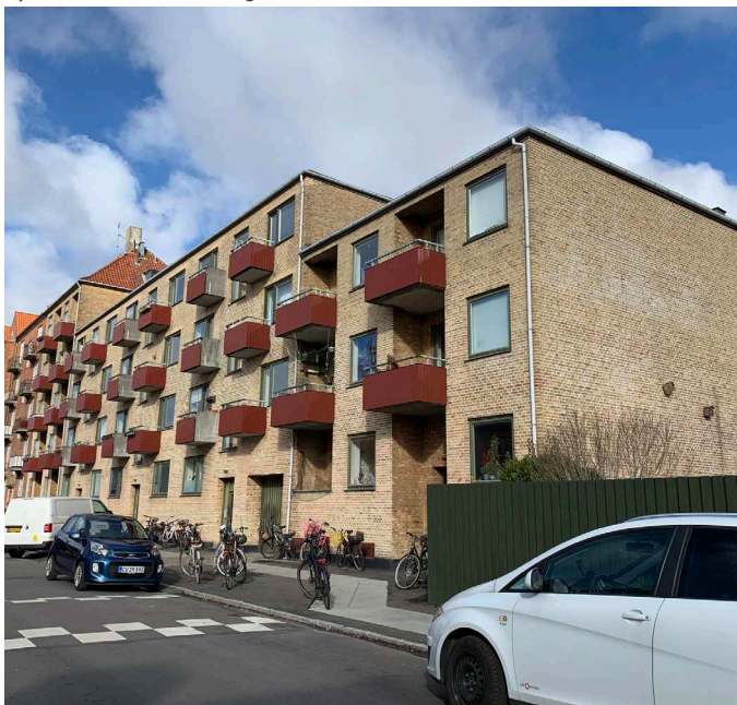
Ejendommen set fra gaden
