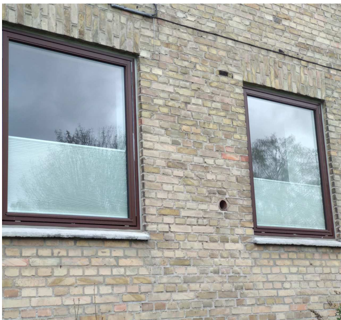
Eksisterende vinduer og facade
