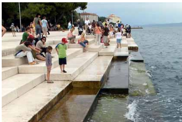
Eksempel på en kombineret promenade og brygge med direkte adgang til vandet
