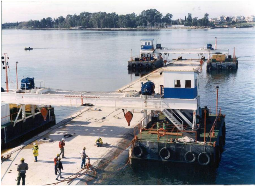
Figur 6.17 Preveza-Aktio tunnel Grækenland – Udflåding af tunnelelement
