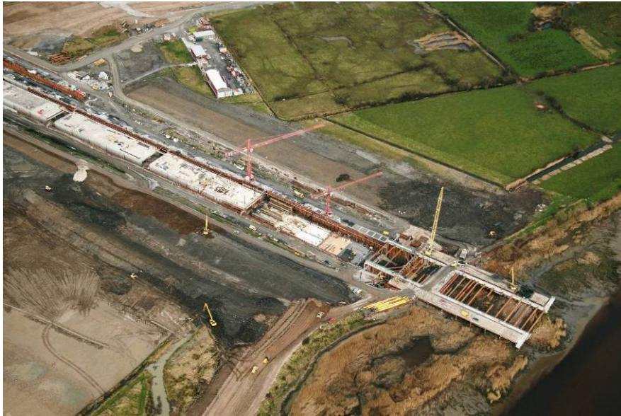
Figur 6.16 Limerick tunnel Irland – Bygning af tunnelelementer i fremtidig rampeområde
