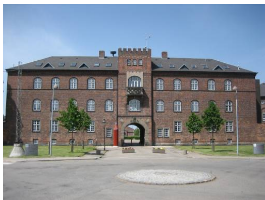
Figur 9.8 Hovedbygning på Svanemøllens Kaserne
