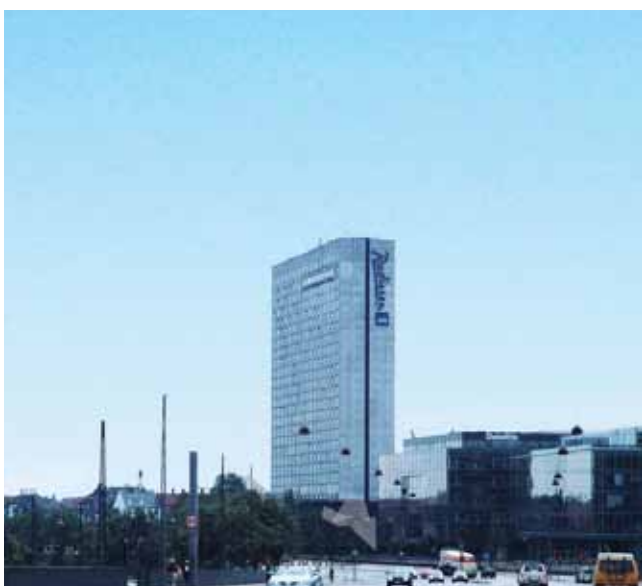
Eksisterende forhold set fra Langebro.
