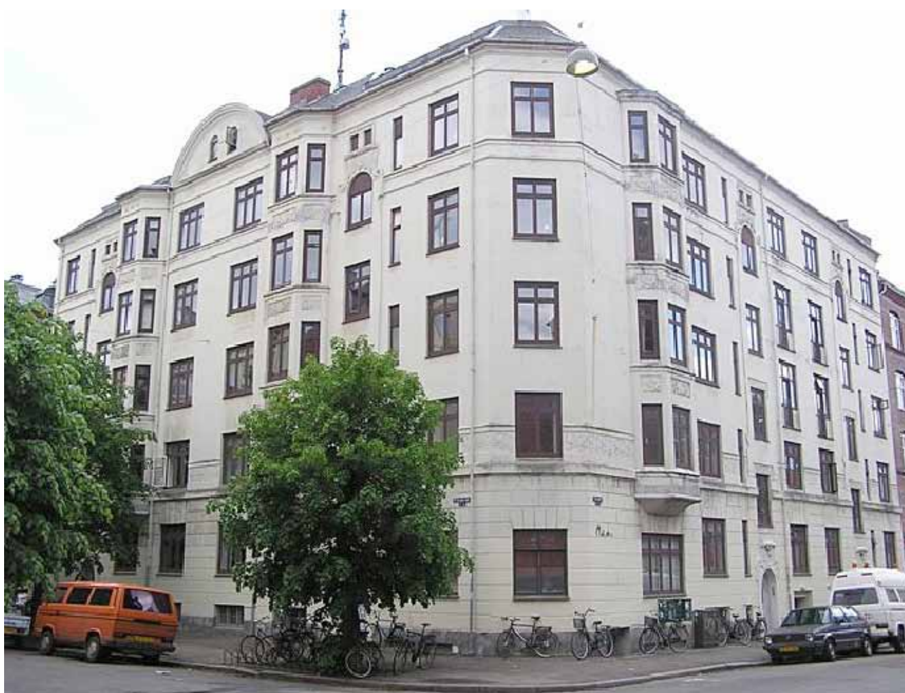
P.D. Løvs Allé 11-13/Thorsgade 64-66 for renovering af klimaskærmen. Der er ydet støtte til tag og istandsættelse af vinduer på både gade- og gårdfacade.
