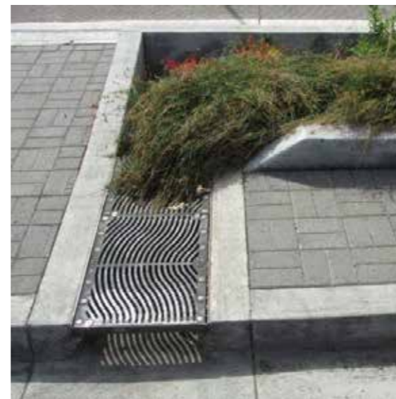
Grøn regnvandsforsinkelse langs gade i Portland, USA
