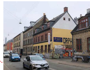
Nordre Fasanvej 273, Kondemnable
