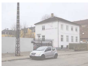
Eksist. villa på Svanevej 7
