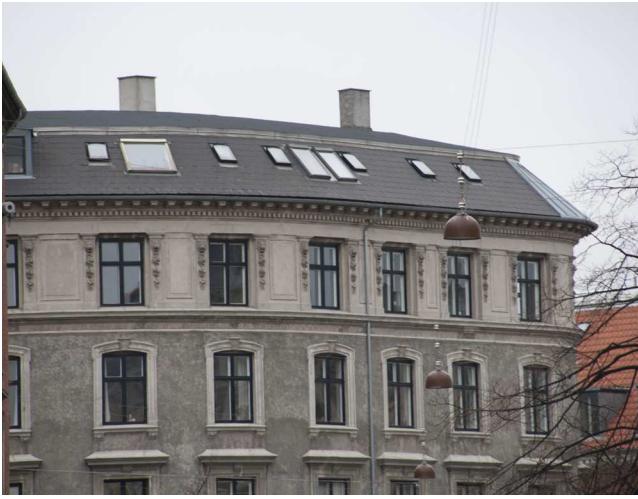
Foto 14. Små og store tagvinduer i en blanding uden rytme og harmoni. De små tagvinduer er sandsynligvis originale, mens de store tagvinduer er en senere tilføjelse.
