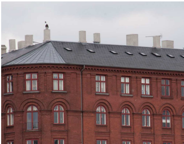
Foto 4. Små tagvinduer placeret rytmisk. Der kan i dette tilfælde fjernes mange skorstene, da de ikke er karaktergivende for bygningen.
