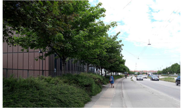
Bebyggelses- og beplantningskarakter langs Sjællandsbroen.
