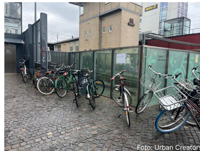
Metroens hvilespor på Vanløse Torv foran indgang til cykelparkering (uden for billedet).
