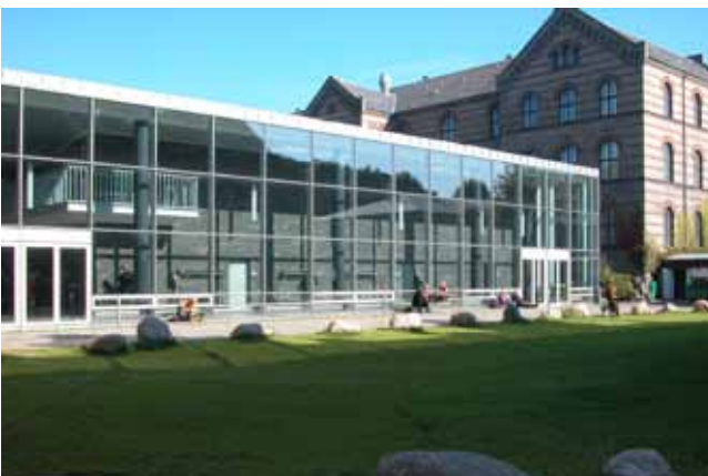
Auditoriebygningen, bygning 34, fra 2006 er placeret i et af haverummene mellem de gamle bygninger.
