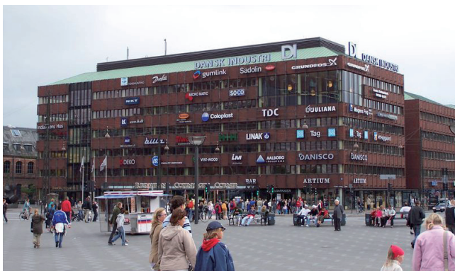
Industriens Hus, opført 1978-80. (Arkitekt Erik Møller).
