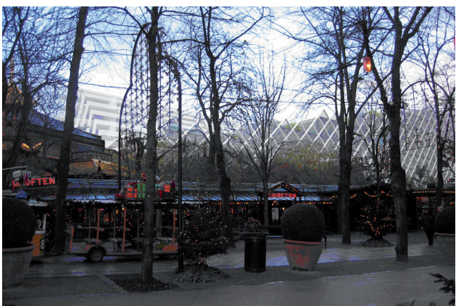
Groften - efter. Nedtrapping af facaden mod Pantomimeteatret.
