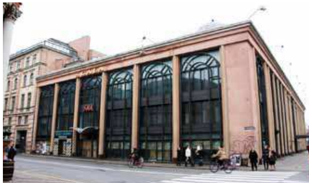
I 1988-1989 blev Scala, tegnet af arkitekten Mogens Breyen, opført med butikker, restauranter, fitnesscenter, biograf samt et diskotek i hælderens.
