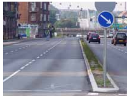
Støjreducerende vejbelægning på Lyngbyvej
