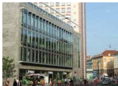
Glasinddækning ved kontorbyggeri på Frederiksberg
