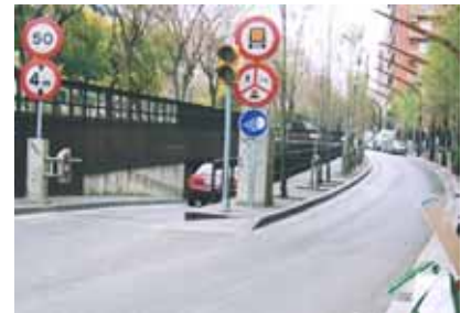
Overdækning af 4-sporet ringvej i Barcelona
