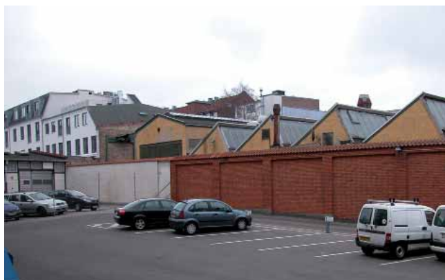
Eksisterende bebyggelse set fra øst - gården til Hejrevej 28
