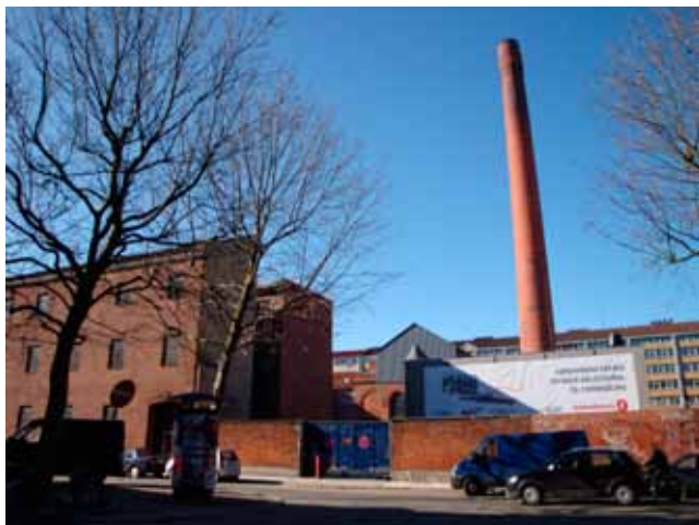
Elværksgrunden i Borgergade overfor lokalplanområdet.
