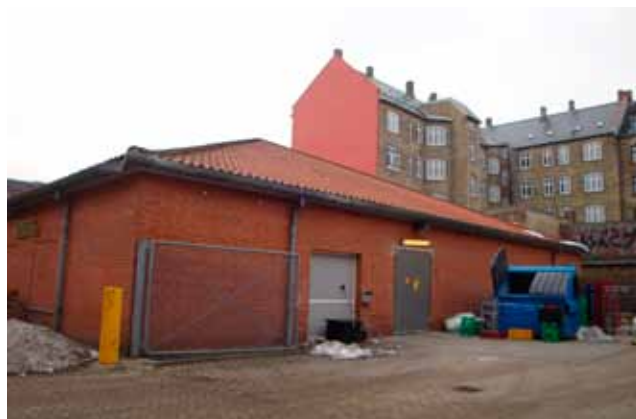
Nettobutikken på hjørnet af Middelgrundsvej og Strickersvej ønsker at udvide butikken og samtidig lave en lille tagterrasse til brug for opholdsareal for personalet.
