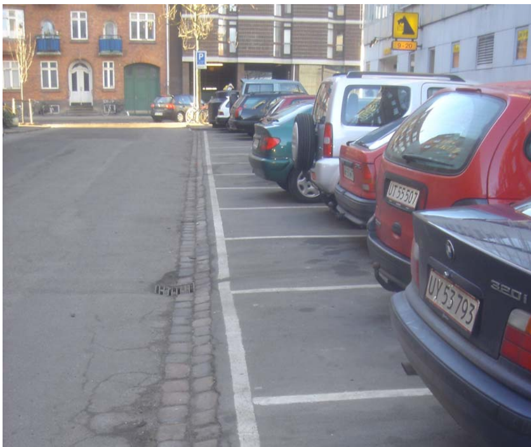
Figur 20. Eksempel i Korsørgade på inddragelse af fortov til parkering og etablering af rampe i brosten mellem kørebane og parkering.
