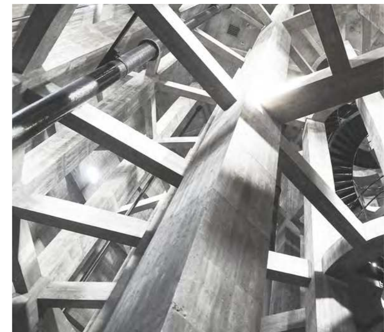
Søjlerummet som bærer den gamle vandtank
