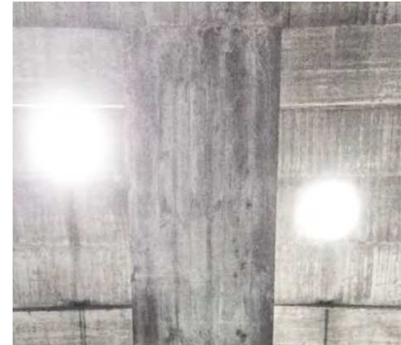
Vinduer i søjlerummet
