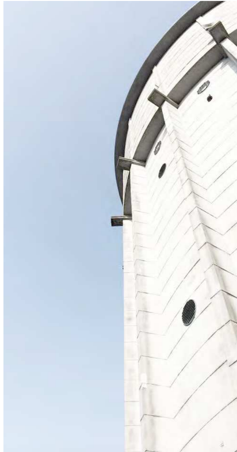
Brønshøj Vandtårns betonfacade
