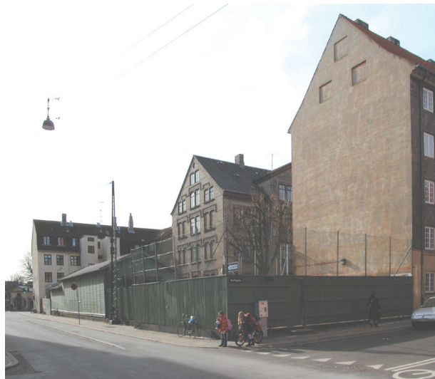
Karreens facade mod Kronprinsessegade. Den nye skolebygning, der sammenbygges med og tilpasses stiftelsen i Klerkegade, vil medvirke til at stramme det i dag noget diffuse gadeforløb op.
