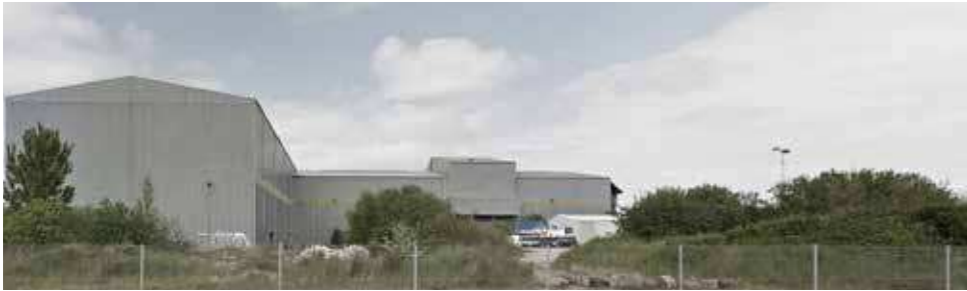
ØTC-hallen Den gamle fabrik omdannes til nyt aktivt knudepunkt
