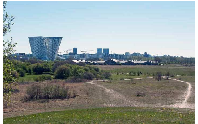
Billede set fra nord mod syd, hvor man kan se det eksisterende vandrehjem og Bella Kvarter i baggrunden. Rettighedshaver: Bygherre.
