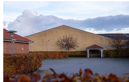
Jorisvej 11a – Gavl fra fabrikshal opført i 1969.
