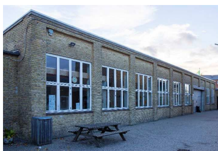
Engvej 145 - Fabriksbygning opført i 1961.
