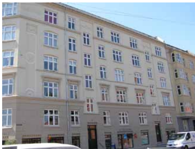
Kastrupvej 4-6 efter byfornyelse.
