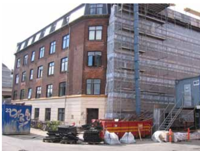
Bregnerødgade 8-18: Bygningsfornyelse i proces.
