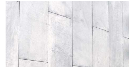
▲ Materiale reference på galvaniseret stål facade
