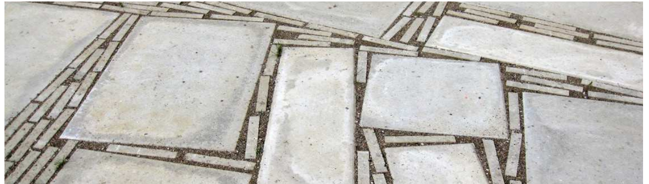
Betonfliser og grus i mønster ud mod Ryesgade.
