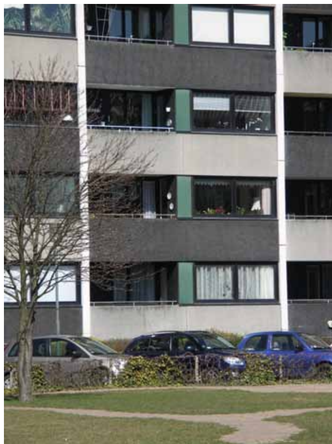
Udsnit af facade mod gård
